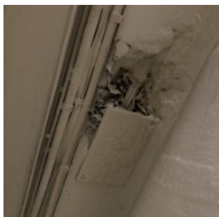
Installation i loft i kælder.
