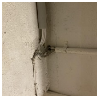
Installationsgennemføring i kælder i loft og væg.
