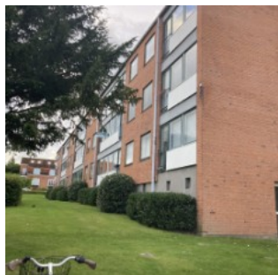
Bagside af ejendommen.
